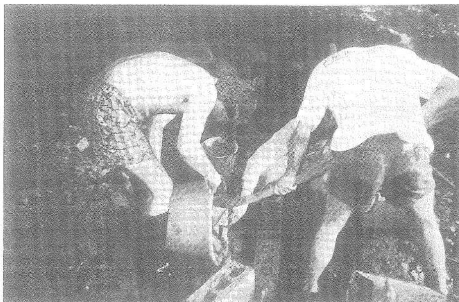
Construction de la digue à l'entrée du B5. Cliché P. De Bie.
