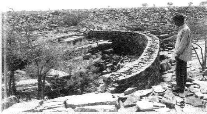
Photo 2 : Belum Guhalu Vue générale du site de Belum Guhalu avec le mur de protection.
