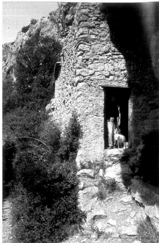
Abri de la Roque Cliché : C. Vertonghen
