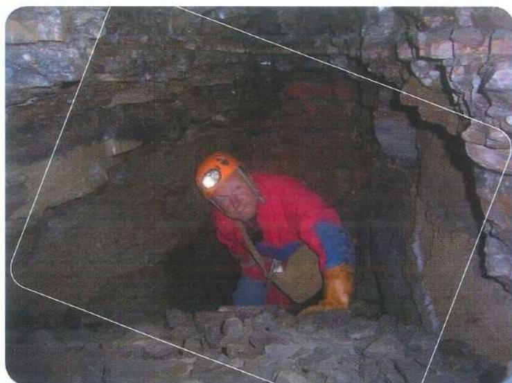
Traversée d'une portion de tunnel non briquetée et éboulée.
