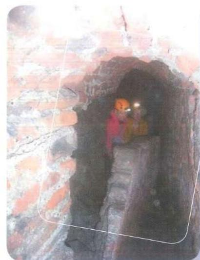
Pan de mur détaché dans une partie briquetée. Cliché : P. Dumoulin
