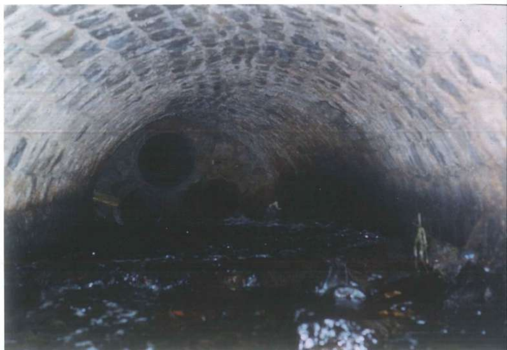
Figure 2. La Magne – Entrée du vieux tunnel vue de l'intérieur, les 3 tuyaux en période de basses eaux. Photo Francis Polrot 1995.
