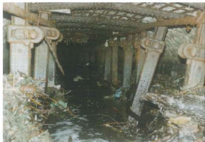
Figure 6. La Magne – Vieux tunnel, structures de soutien. Photo Francis Polrot.
