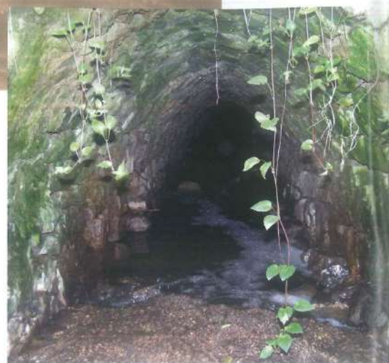
Figure 13. La Magne – L'entrée du tunnel du ru des Carrières. - Photo Francis Polrot.
