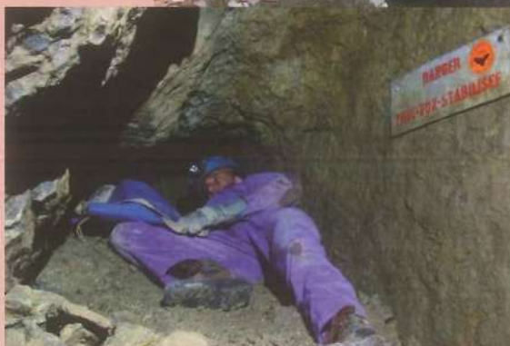
Robert Levêque dirige les travaux de stabilisation. Photo Jean-Claude London.
