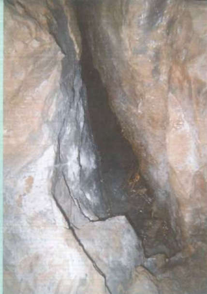
Résultat après nettoyage au burin, marteau et pied de biche.
