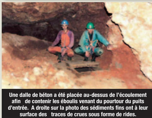
Une dalle de béton a été placée au-dessus de l'écoulement afin de contenir les éboulis venant du pourtour du puits d'entrée. A droite sur la photo des sédiments fins ont à leur surface des traces de crues sous forme de rides.
