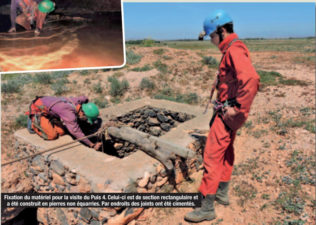
Fixation du matériel pour la visite du Puits 4. Celui-ci est de section rectangulaire et a été construit en pierres non équarries. Par endroits des joints ont été cimentés.
