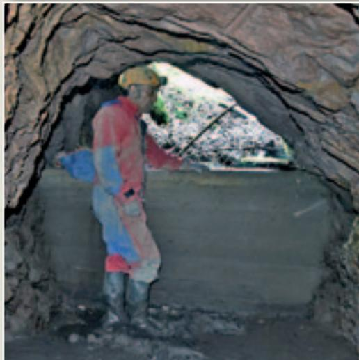
5. Le muret en béton qui barre la galerie, ménageant un réservoir en amont. (© P. Du.)
