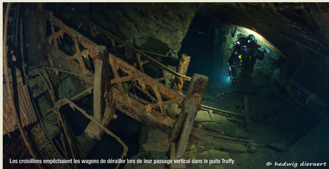
Echelles de remontée des ouvriers
