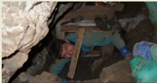
29 - Alors que le béton était encore frais, Kris est le premier à ramper à travers la porte nouvellement installée. C'était un poids en moins sur nos estomacs que la grotte soit définitivement sécurisée contre les visiteurs indésirables. Photo : Geert De Sadelaer
