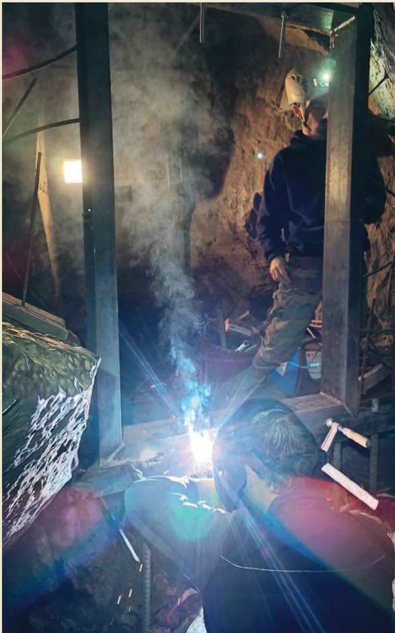
*Après boulonnage au plafond, Maxime soude l'encadrement sur la poutrelle inférieure.*
